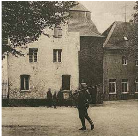
Im I. Weltkrieg nutzte das in Kaiserswerth stationierte Militär das Haus als Wachstube und für eine gemeinschaftliche Brauseanlage
